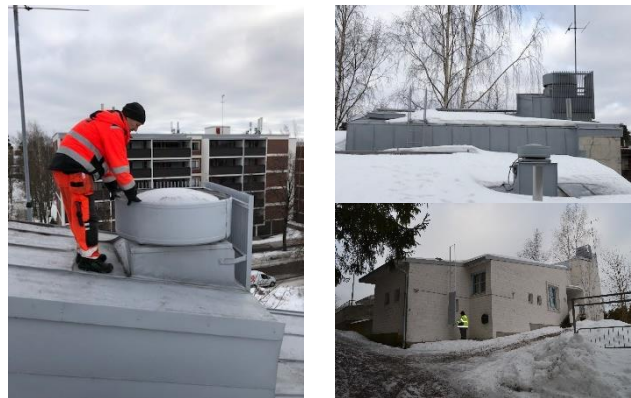
Ulkoilmalaitteet ja erillispoistot tarkastetaan yleensä vesikatolla
