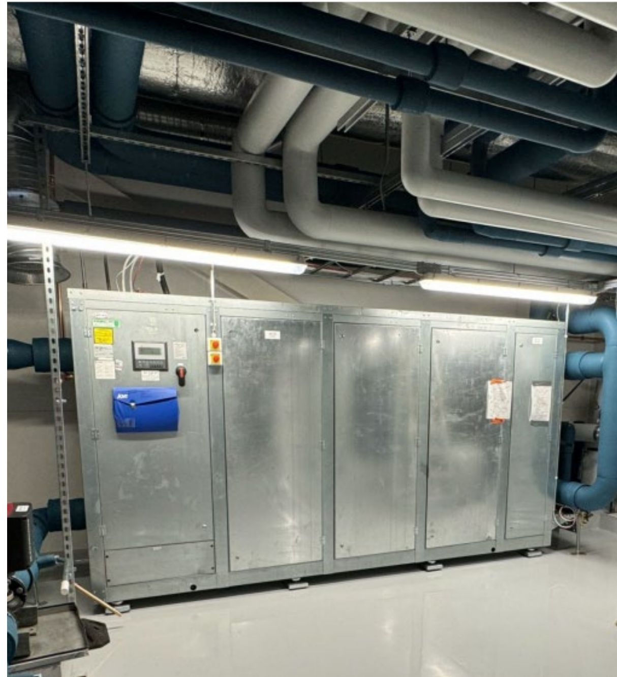
Kuva: Vedenjäähdytyskone asennettuna uudiskohteessa. (Lähde: Ärväs, 2024)
